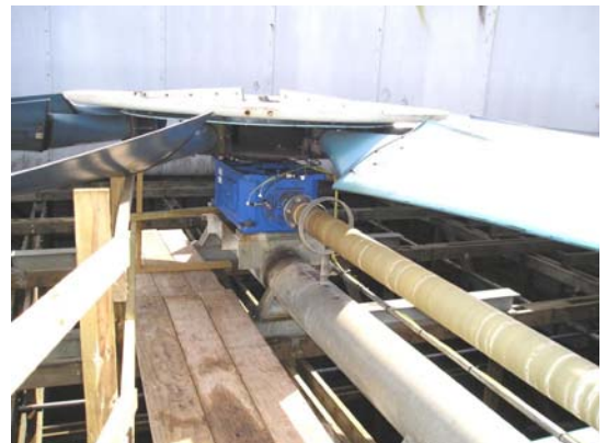
监测冷却塔的振动值
