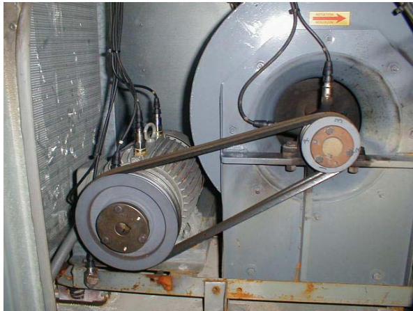
监测电机和风扇的振动值
